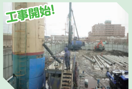
3月19日より工事が開始されました。
